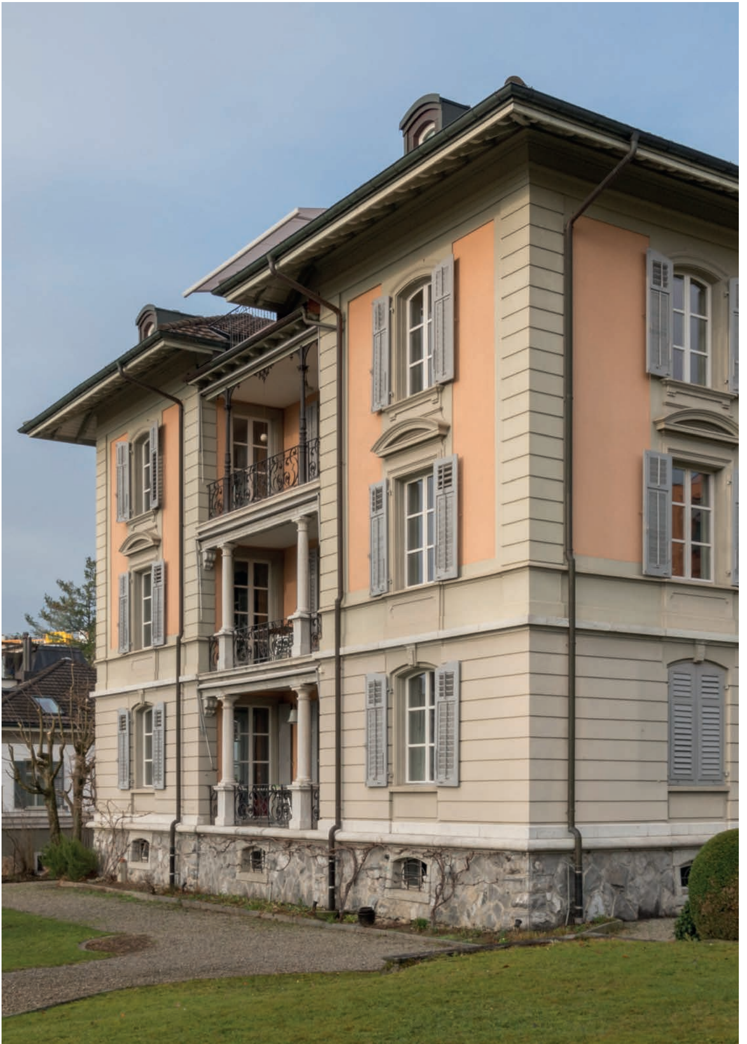
Umbau MFH Lindenfeldsteig, Luzern
