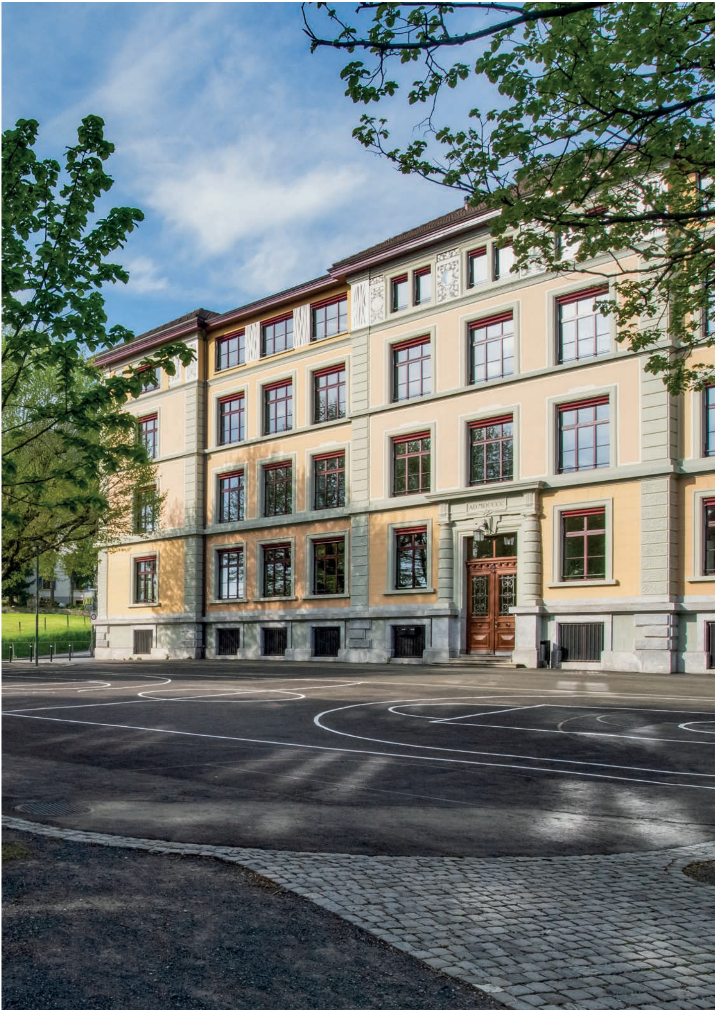
Gesamtsanierung Schulhaus Kirchbühl 1+2, Kriens
