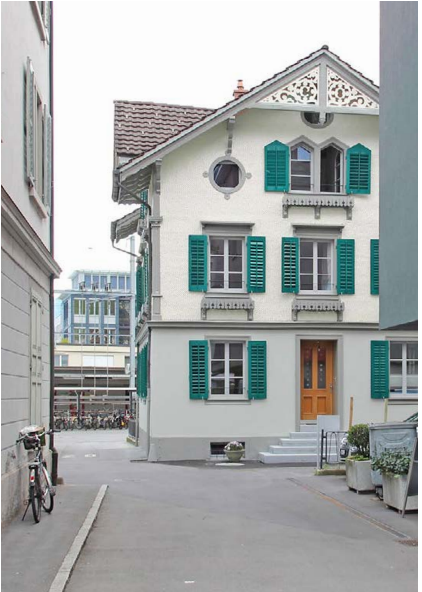
Gesamtsanierung EFH, Stans
