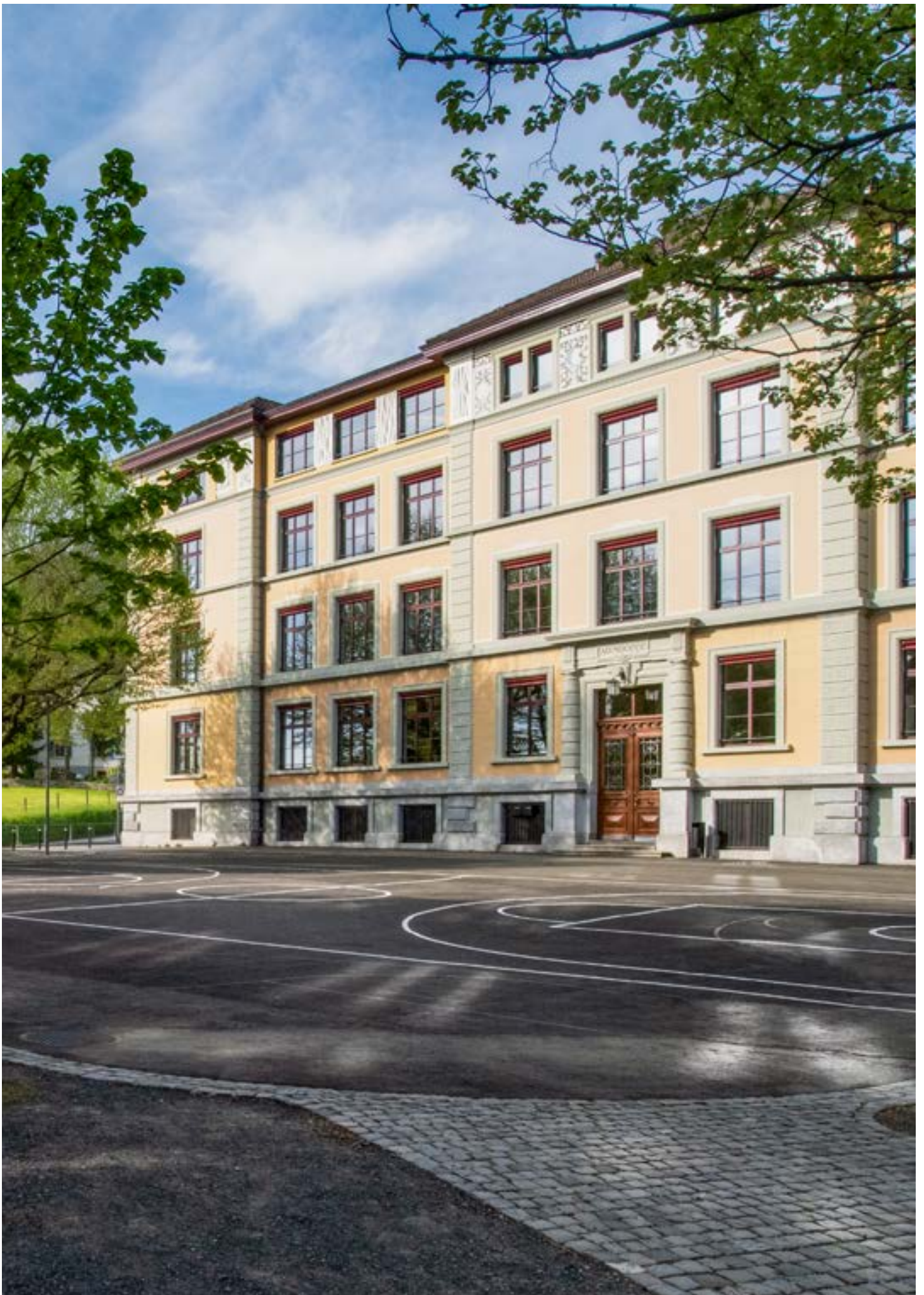
Gesamtsanierung Schulhaus Kirchbühl 1+2, Kriens
