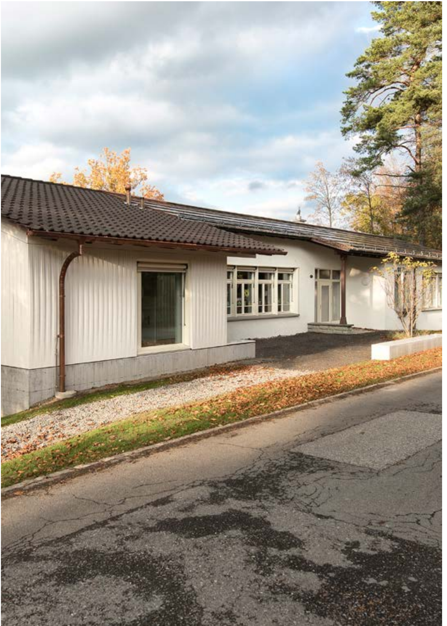
Neubau / Sanierung Schulhaus Innerschachen, Ebikon
