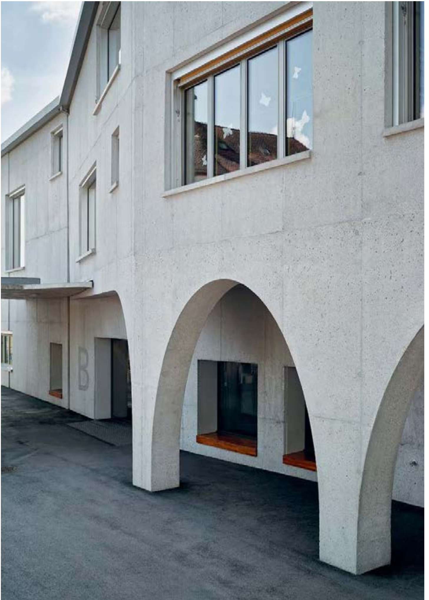
Neubau Schulhaus Trakt B, Buttisholz
